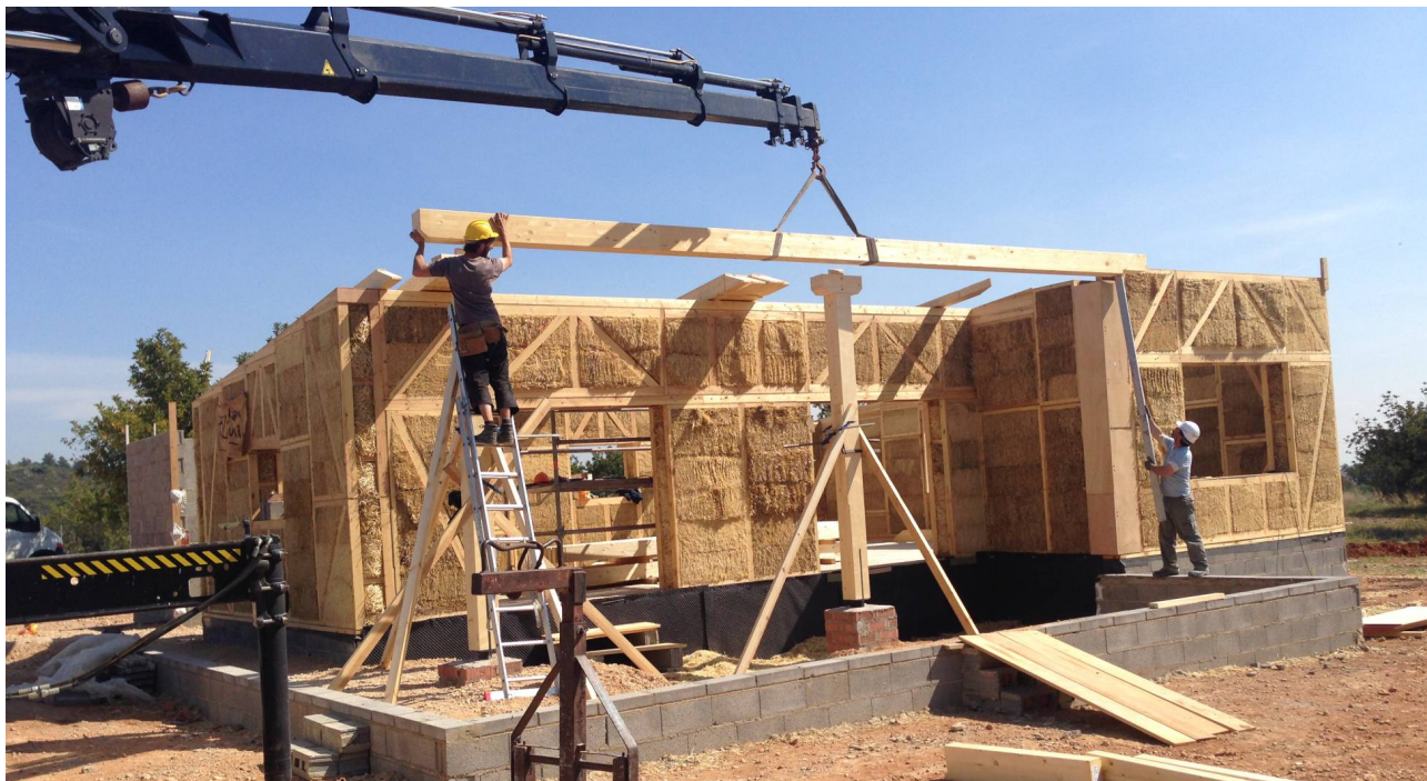
Vivienda unifamiliar con módulos prefabricados de Okambuva en Chiva (Valencia) realizada por los arquitectos Emma Martínez y Juan Pablo Pellicer.
